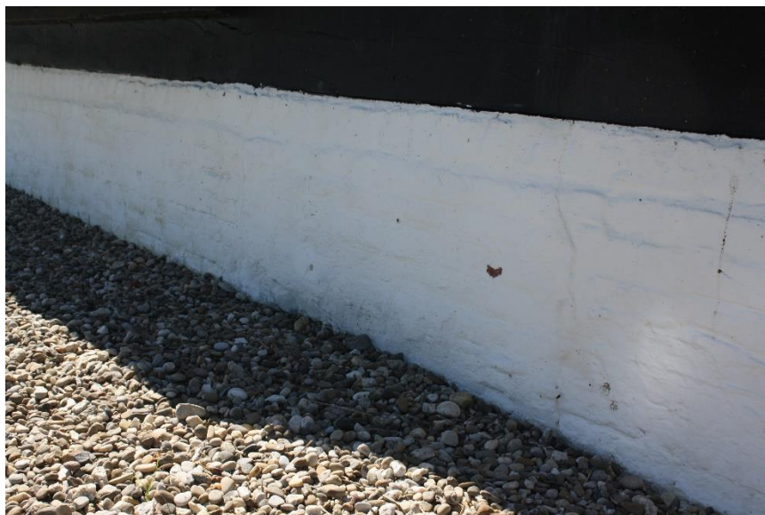
afb. 66 Oude Weteringmolen, oostelijke muur met sporen van het bakhuis/bakoven
