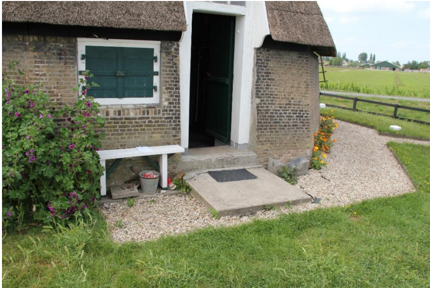
afb. 19 Het grindpad rond de molen aan westelijke zijde met rechts het toepad vanaf de Tiendweg. Voor de toegangsdeur een betonnen plateau.
