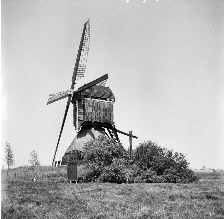
afb. 60 Oude Weteringmolen gezien vanuit het zuidwesten. Op de voorgrond een steiger waarop het gemak is geplaatst.
