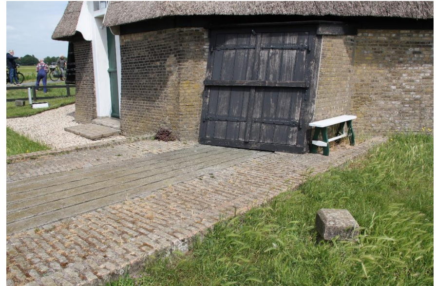
afb. 20 Zicht op de sprenkelstraat met daarachter het grindpad rond de molen en geheel links het toepad vanaf de Tiendweg. Voor de toegangsdeur liggen in baksteen opgesloten grijze tegels.
