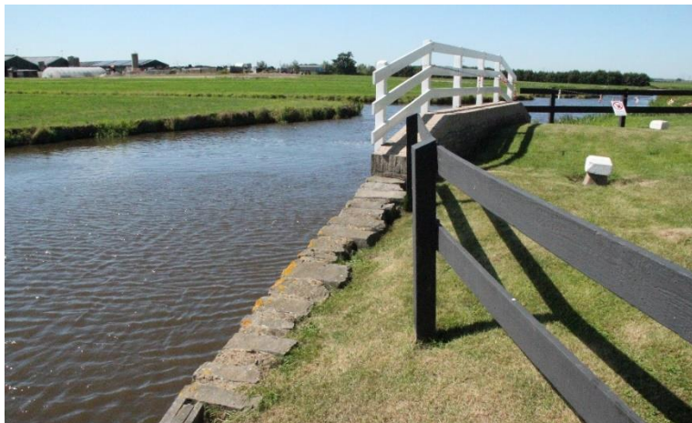
afb. 64 Oude Weteringmolen, hekwerk en waterloophek
