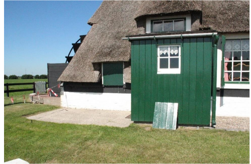
afb. 68 Oude Weteringmolen, het erf ten westen van het klompenhok is voorzien van gewassen grindtegels
