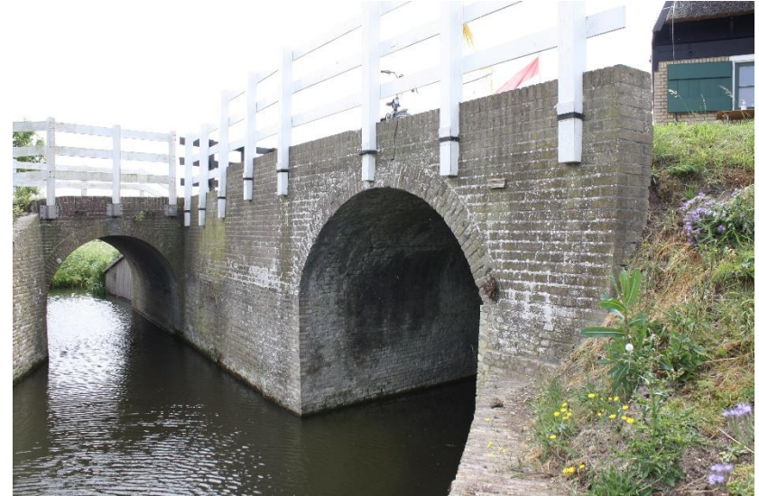
afb. 36 Het waterloophek van de achterwaterloop. De staanders van het waterloophek zijn op de traditionele wijze tegen de frontmuur bevestigd. De staanders van het hekwerk van de brug (dat onder de verantwoordelijkheid van het waterschap valt) worden in recente, detonerende houders geklemd (zie ook afb. 35), terwijl de oorspronkelijke beugels nog aanwezig zijn. In tegenstelling tot het waterloophek, is het hek op de brug van kunststof. Dergelijke hekken en de bevestiging van deze hekken is door het waterschap op alle bruggen/duikers in het gebied consequent toegepast.
