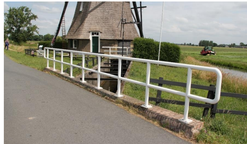
afb. 15 Het erf van de Achtkante Molen met het hek ten noorden van de voorwaterloop, het waterloophek en het hekwerk van de brug in de Tiendweg
