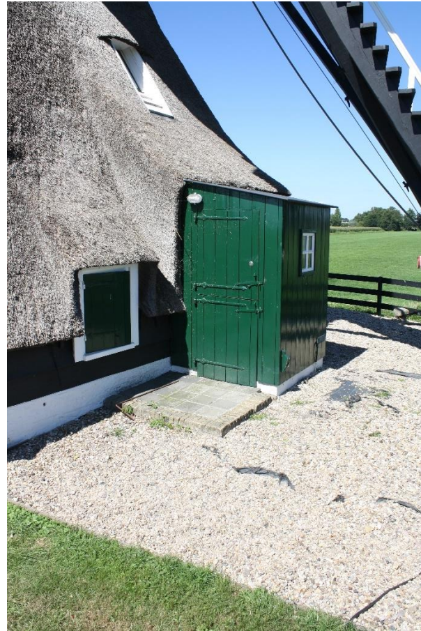
afb. 97 Brede zone met grind met voor het klompenhok grijze tegels opgesloten in een baksteenrand.
