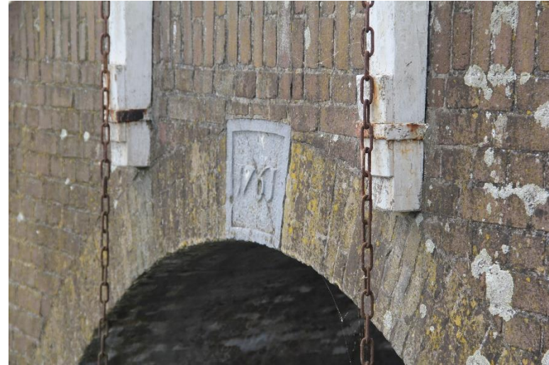
afb. 9 De sluitsteen van het gewelf van de frontmuur van de achterwaterloop
