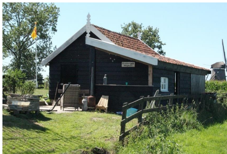
afb. 95 Schuur vanuit het oosten
