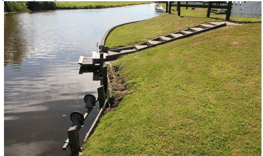
afb. 70 Oude Weteringmolen, in het talud aan de oostzijde zijn traptreden in het talud ingelaten die leiden naar een kleine vlonder.
