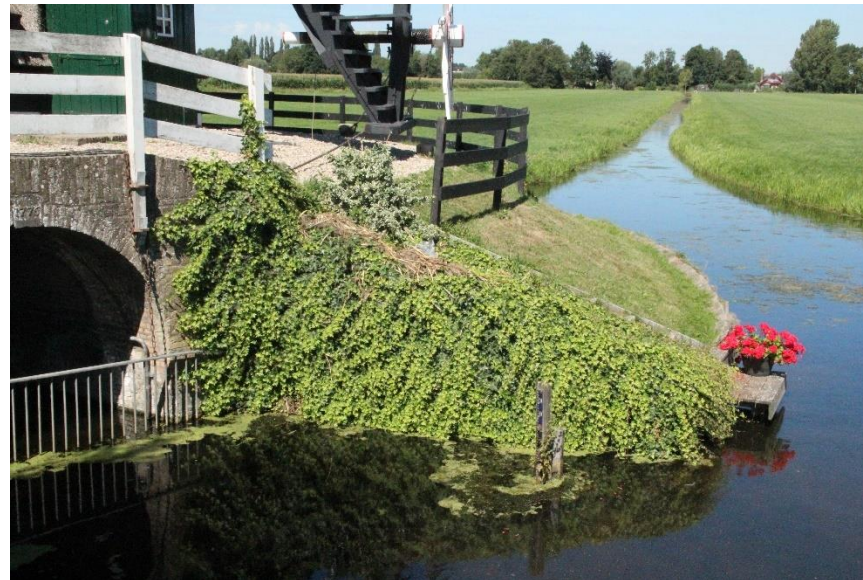
afb. 99 De basaltstenen rechter wang van de voorwaterloop is overgroeid
