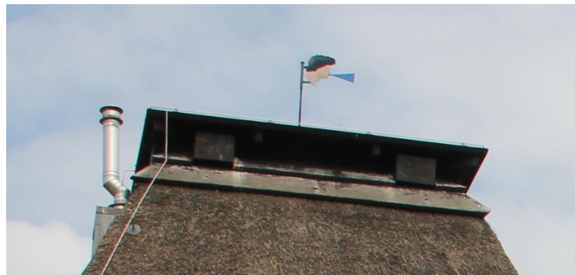
afb. 27 De huidige windvaan op de ondertoren van de Hoge Tiendwegse Molen
