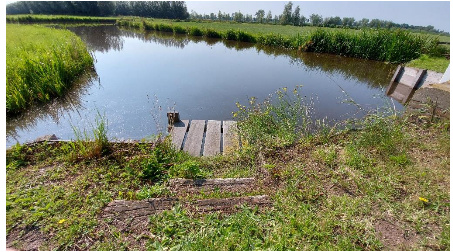
afb. 33 Boenstoep (niet oorspronkelijk) ten noorden van de achterwaterloop met enkele bielzen ingelaten in het talud als traptreden
