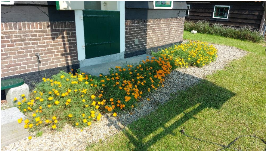
afb. 31 Voor beide deuren van de molen ligt een betonnen "stoep" in het grindbed.
