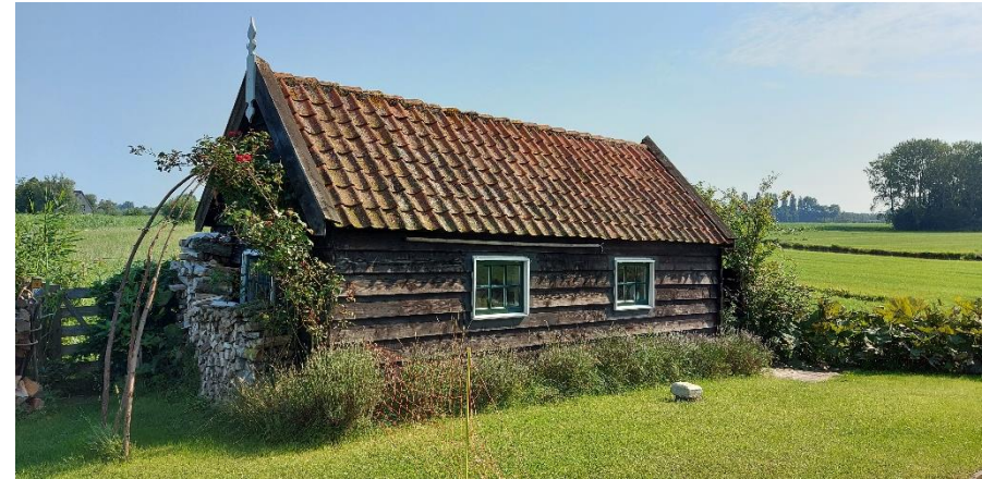
afb. 17 Schuur, topgevel (noordwest) en zijgevel (zuidwest), 2021
