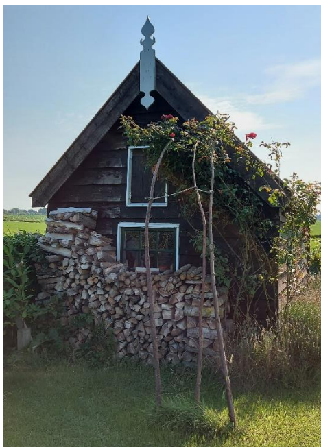
afb. 20 Schuur, topgevel (noordwest), 2021
