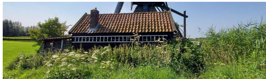
afb. 22 De schuur met aangebouwd houthok (links) vormt de afscheiding (noordoost)
