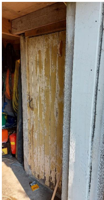
afb. 19 Schuur, 2021, interieur met rechts de toegang tot het oorspronkelijke gemak
