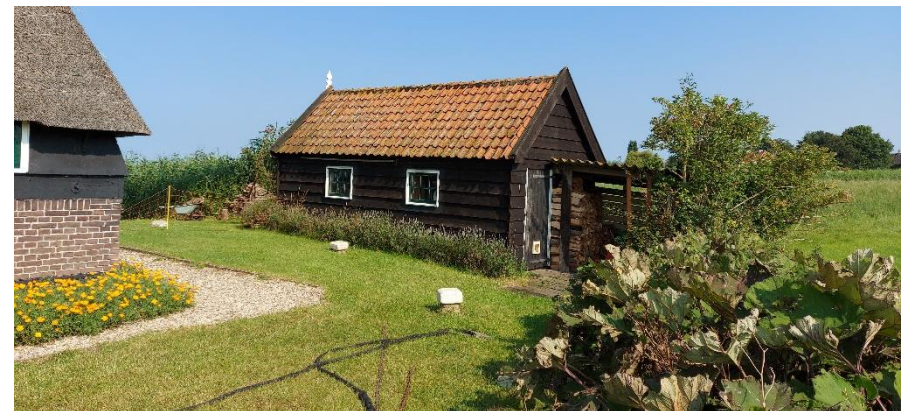
afb. 18 Schuur, topgevel (zuidoost) en zijgevel (zuidwest), 2021
