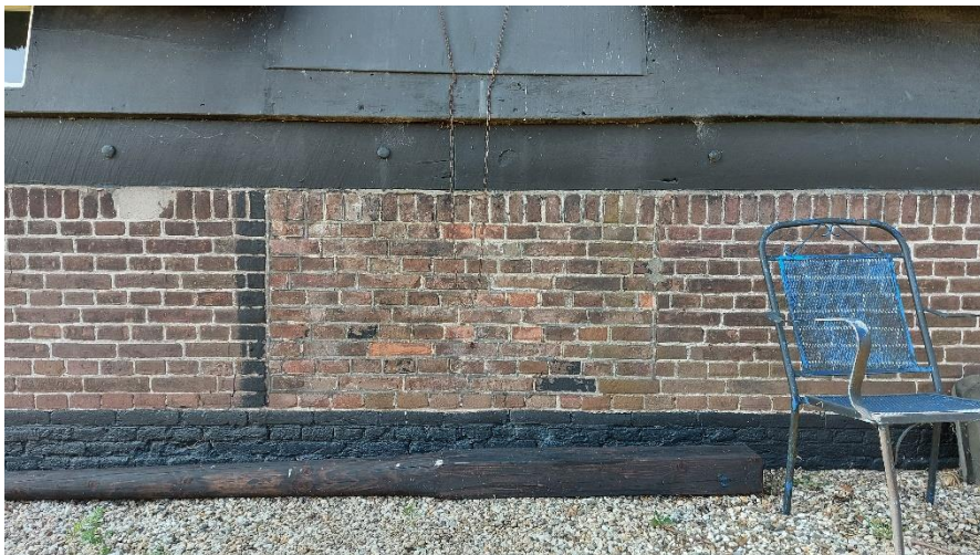
afb. 28 De noordoostelijke veldmuur van de molen. De plek waar de bakoven heeft gezeten is herkenbaar in het metselwerk. De bakoven deelde de schoorsteen van de stookplaats in het interieur. Deze situatie kwam ook voor bij de Oude Weteringmolen in Streefkerk. Ook daar is de bakoven verdwenen.
