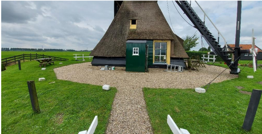
afb. 34 Het molenerf vanuit het oosten, 2021
