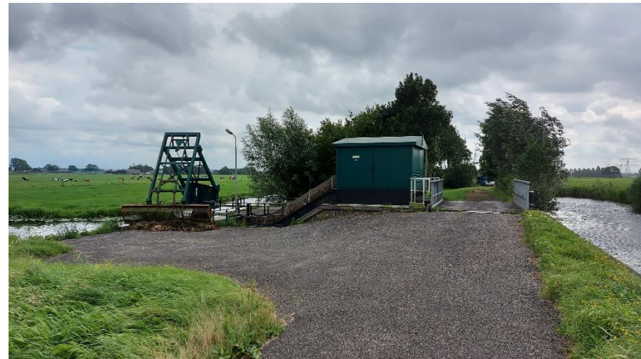
afb. 38 Het gemaal even ten zuiden van de Middelmolen
