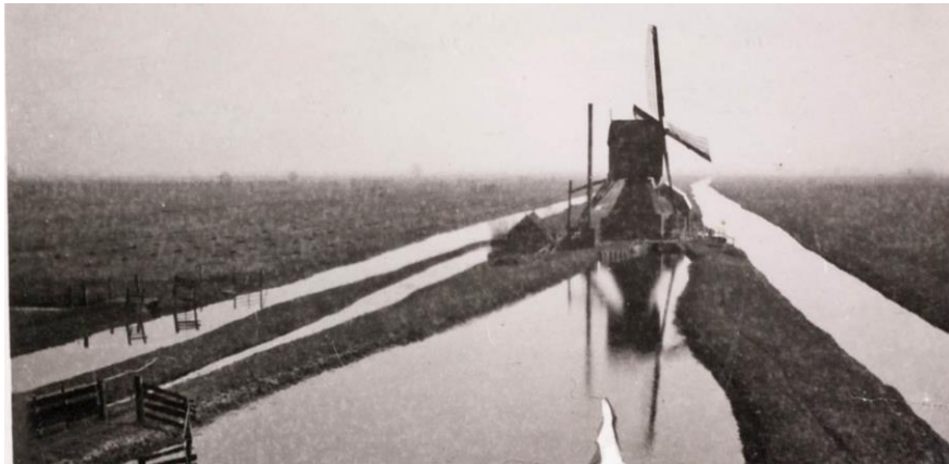
afb. 3 De Zuidmolen gezien over de tussenboezem vanaf de Middelmolen met de schoorsteen van het in de molen geplaatste stoommachine. Datering voor 1951
