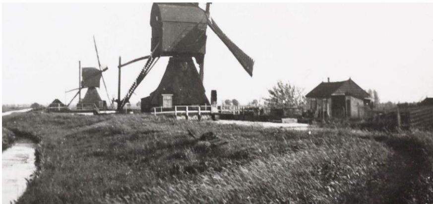
afb. 4 Op de voorgrond de Middelmolen en op de achtergrond de Zuidmolen met schoorsteen naast de molen. Gedateerd juni 1931
