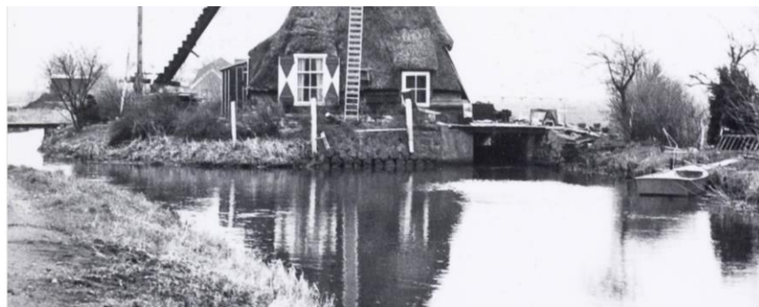
afb. 32 De voorwaterloop, april 1977. Situatie voor de restauratie; de staanders van de oostelijke veiligheidshekken zijn nog aanwezig.
