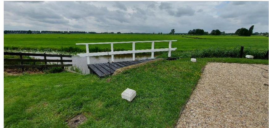
afb. 28 Het achterwaterloophek, 2021, gezien vanuit noordoostelijke richting
