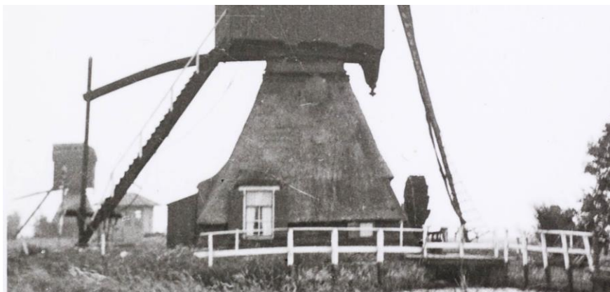
afb. 31 De voorwaterloop, datering tussen 1943 en 1951
