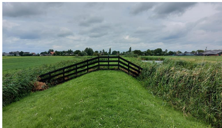
afb. 25 Het afscheidingshek aan de noordzijde, 2021
