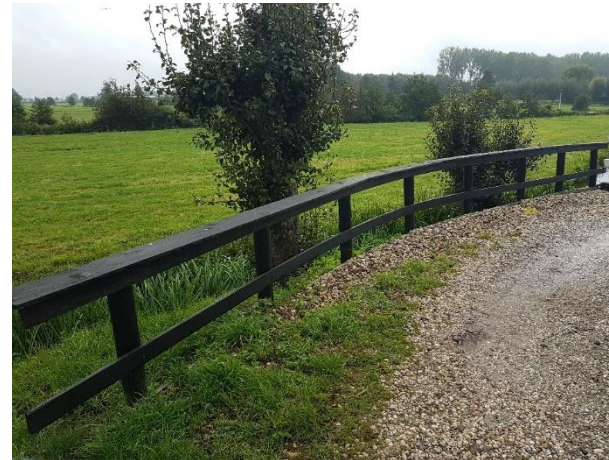
Afb. 18 Houten hekwerk aan de noordoost zijde (2020).
