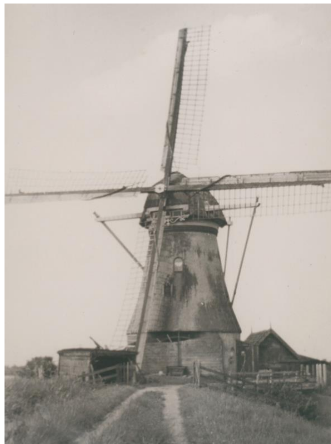
Afb. 7 Kortlandse molen vanuit het zuiden, rond 1935-1940, met schuur onder zadeldak links en wagenschuur rechts.
