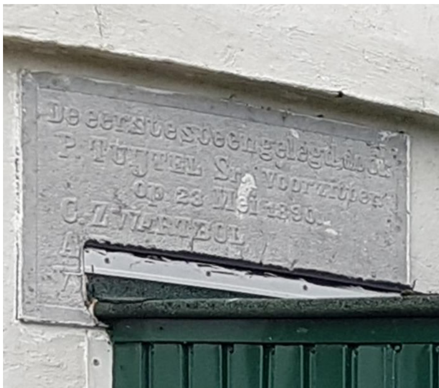
Afb. 11 Detailopname van de gevelsteen. De tekst is door een aanbouw niet geheel zichtbaar.
