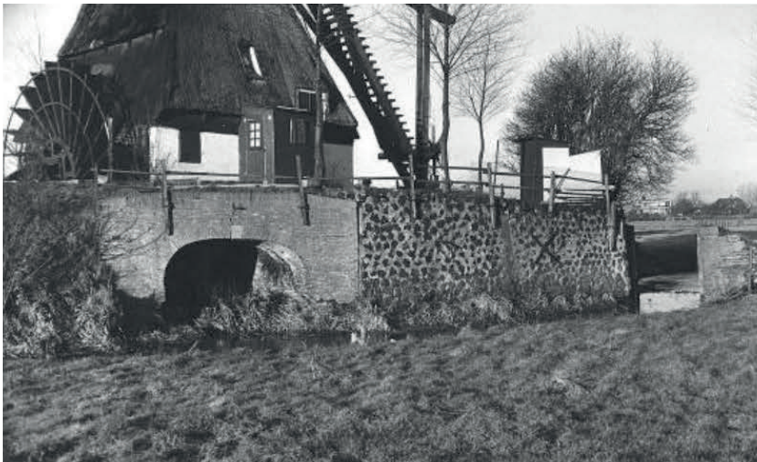
De stenen verhoging met getoogde frontmuur, achterwaterloop en keermuren van basaltzuilen gezien vanaf de Schuine Kolk. (Bron: Den Besten 2008)
