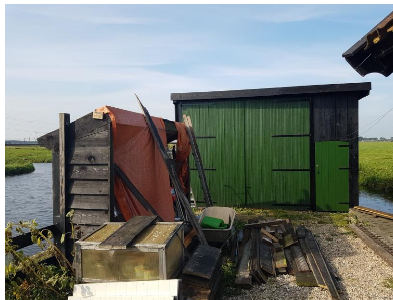
Afb. 13 Recente Schuur aan de achterzijde (west) van het erf.
