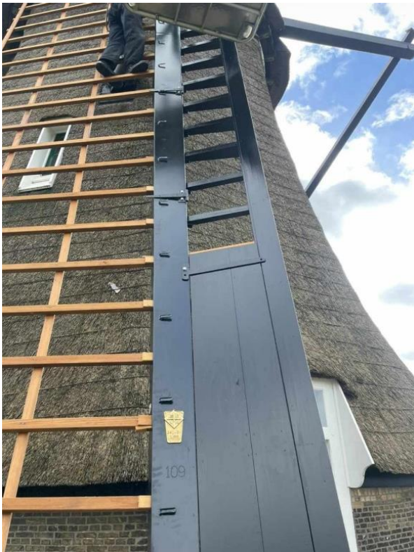
Bevestigen van de windborden.
