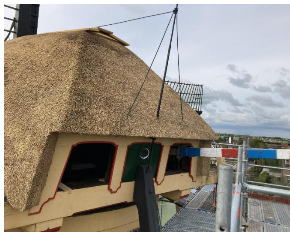
Kerkmolen, Molenaarsgraaf Nieuwe rieten dakbedekking
